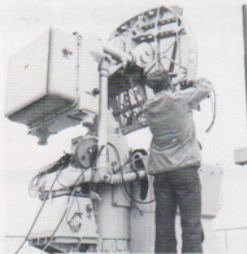
Anders Åkerberg monterar höghastighetskamera i eldledningsradarns sikte.
