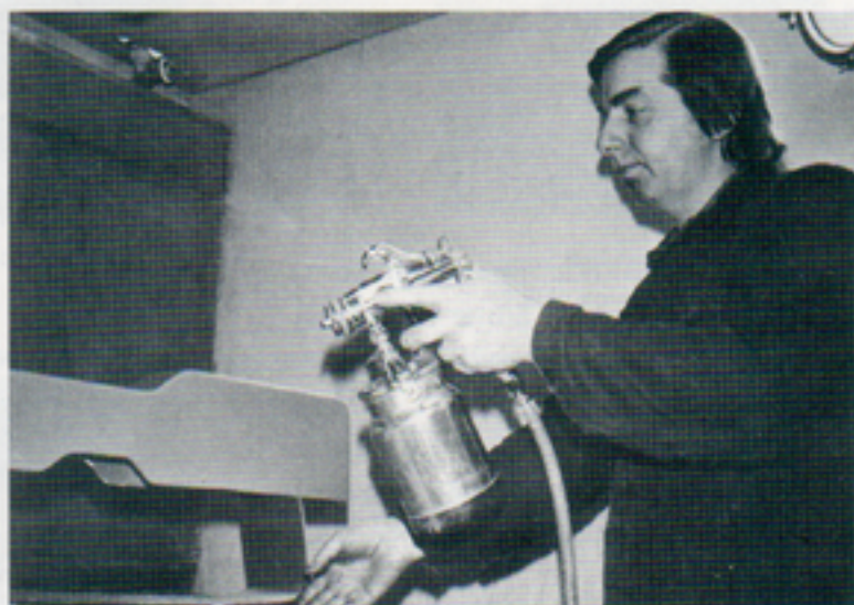
Kamerakåpan av plast sprutmålades av Sven Blomgren
