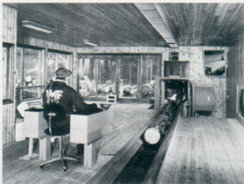
Modern timmertransport och sortering vid AB Ängsågen i Vislanda. Elektroniken har installerats av Remo Electronic och Telub svarar för servicen.
