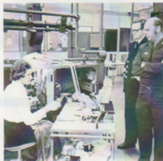
Modifiering av Cig m/48 ef. Gerd Axelsson → byter bandkablar.
