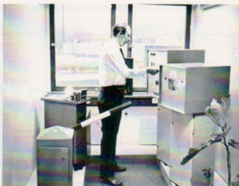
Konstruktören, Sven Magnusson, demonstrerar för red hur parkeringsautomatiken arbetar. Det är inte bara det att bommen går upp när rätt markerad biljett sätts på rätt plats. Man blir också upplyst om sådana förhållanden som att »sedeln är felaktig», »biljetten ogiltig» eller »felvänd» m m.
