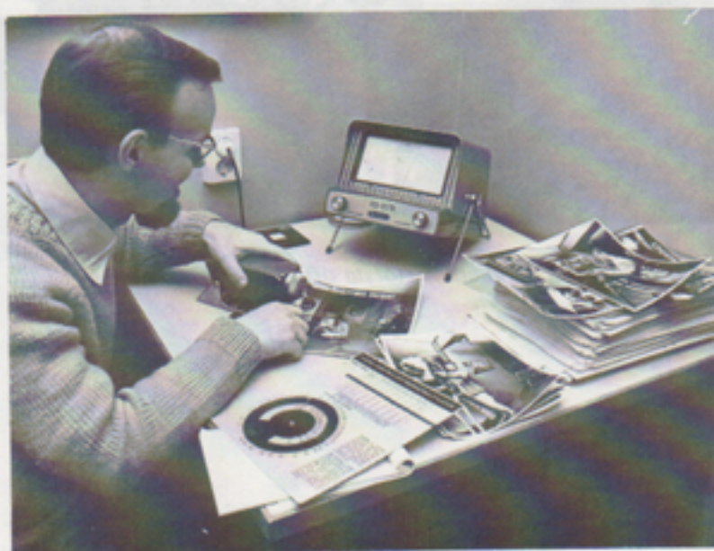
Tonomfånget i bilden mäts i en densitometer för att återgivningen i färdigt tryck skall överensstämma med originalet. Ulf Ljungdahl mäter.
