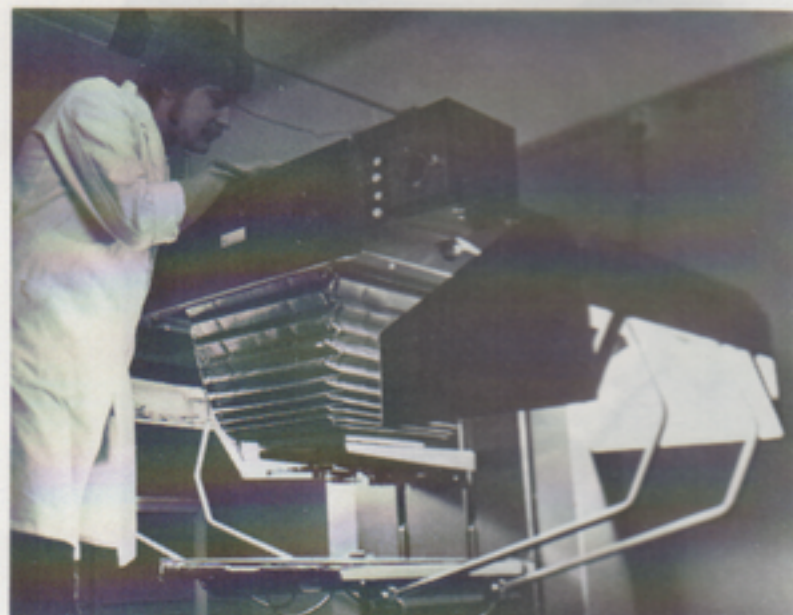
Med reproduktionskamerans hjälp fotograferer Tore Säll tryckoriginalen till negativ.
