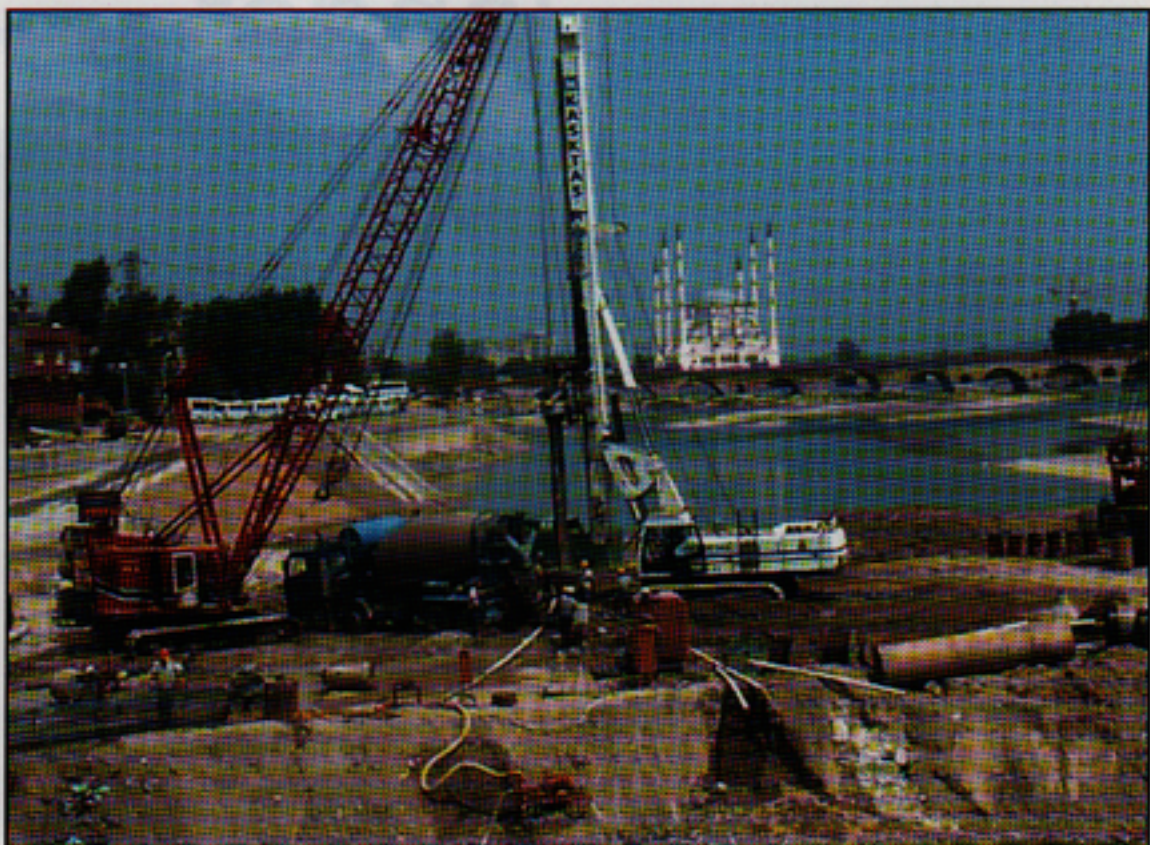
En ny bro byggs över floden Syhan. Floden har nästan torrlagts genom omledning av vattnet. I bakgrunden den gamla antika bron och en nybyggd moské i jätteformat.
