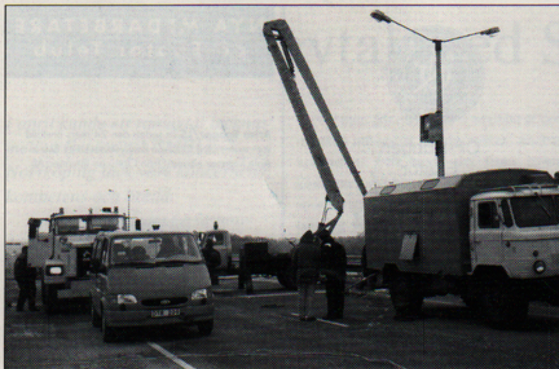
Mats-Olov Rustad och Ingvar Jonsson i färd med att installera och driftsätta VVIS-stationer några kilometer utanför Tallinn i Estland.
