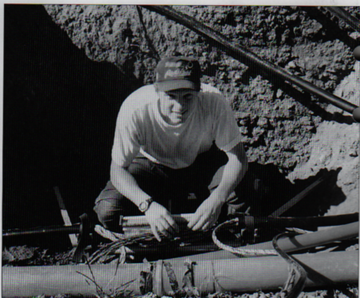
Johan Ljungblom, Telub Teleanläggningar, är en av flera som bland annat skarvar in kablar till Telias koncentratorer.
