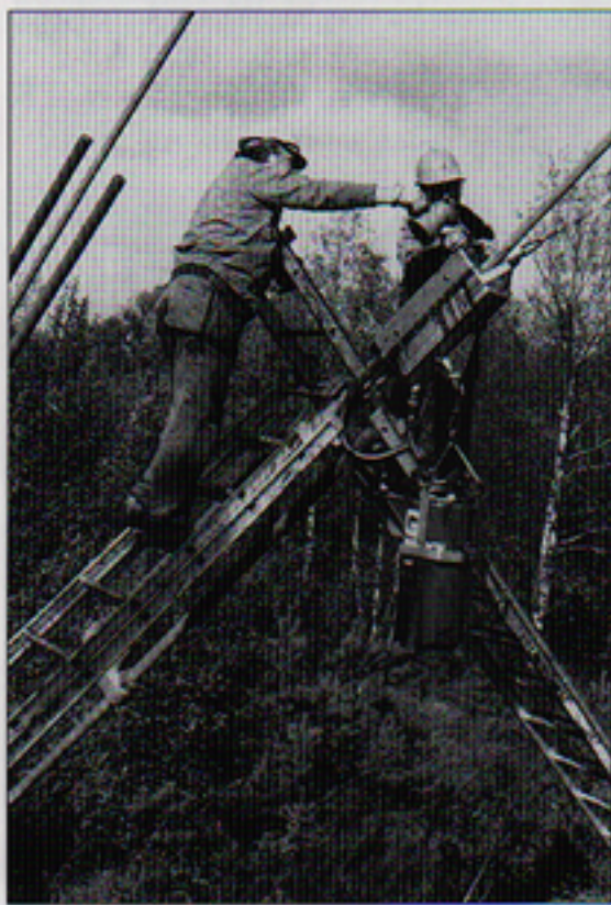
Kurt Kling och Rune Andersson preparerar tanken med rostskyddsmedlet som ska dras sakta upp längs linan.
