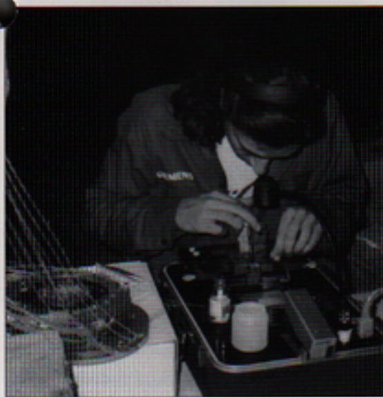
Här skarvar en av de argentinska arbetarna optofiberkabel.
