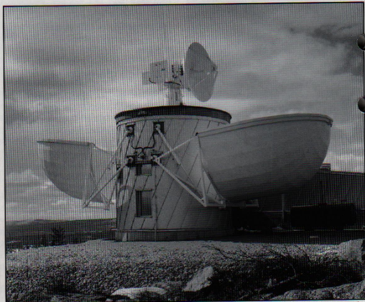
Det några ton tunga vindskyddet har öppnats för att radarn skall kunna fånga upp och sända uppgifter till ledningscentralen om var robot och mål befinner sig.
