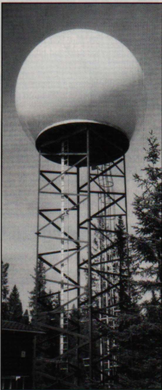
I den här upphöjda "tennisbollen" döljer sig Flygvapnets nya väderradar PV-883.
