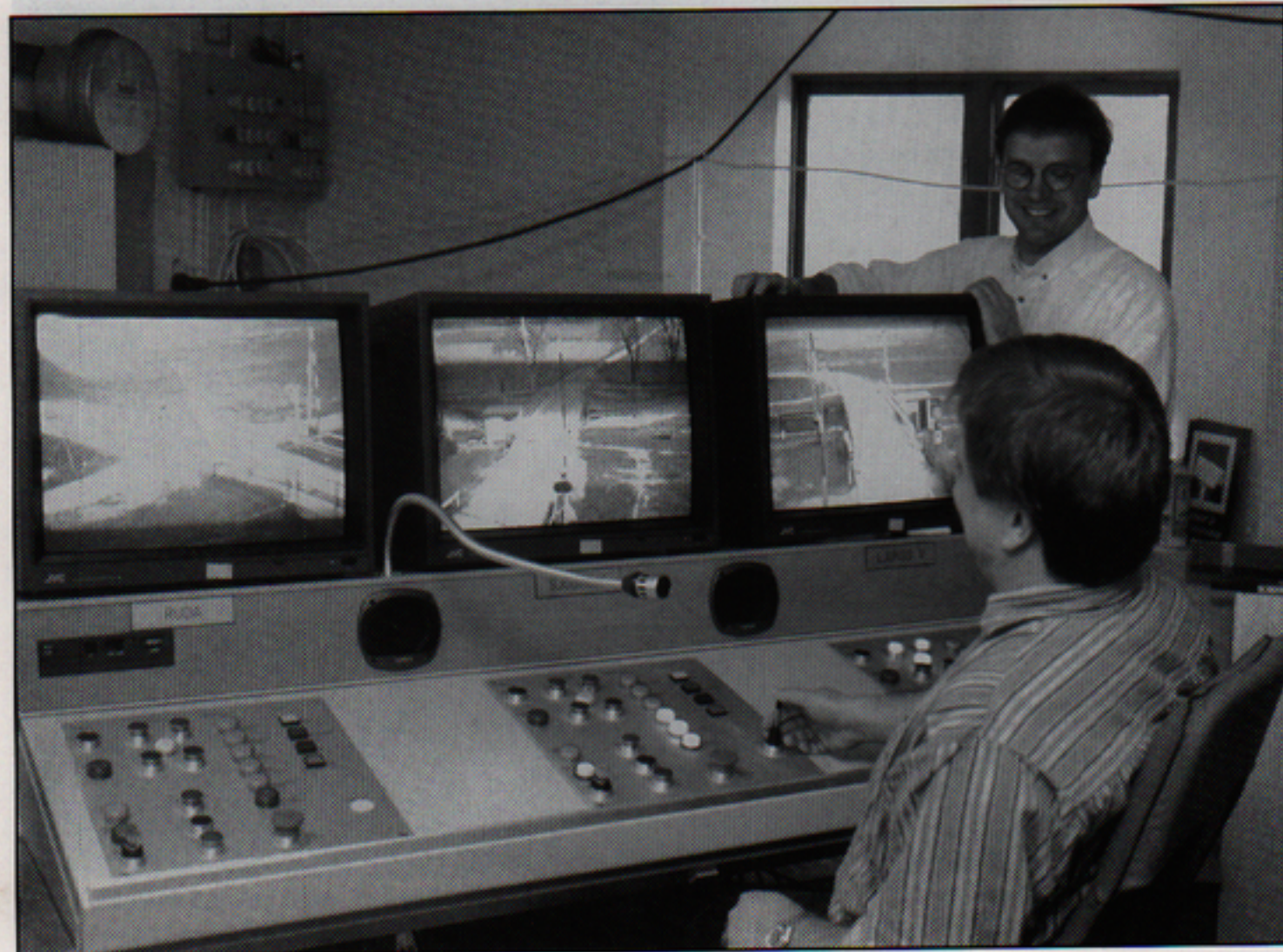
Tommy Eriksson (stående) och Pär Eriksson har "lånat" brovaktens plats och betraktar nöjda sitt verk, bildskärmar och manöverpanel, som hjälper till att övervaka flera broar samtidigt.
