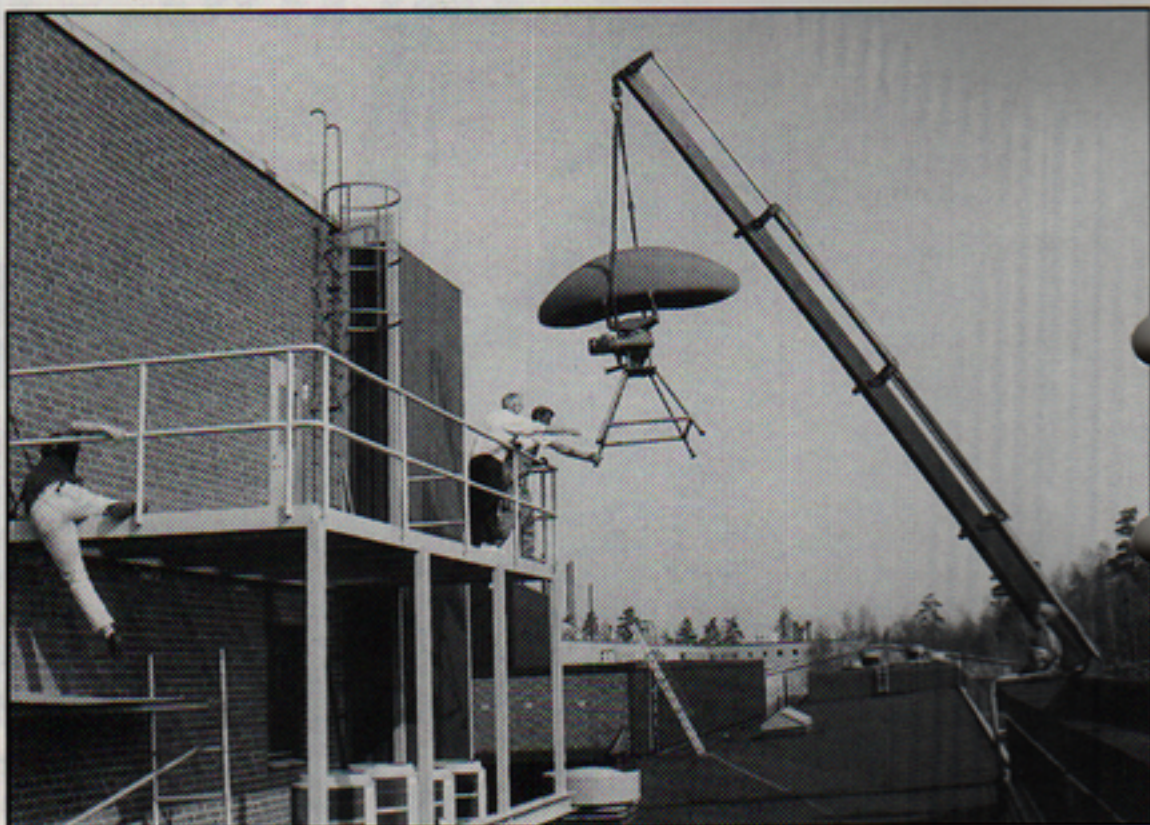
Hjälpande händer och en lyftkran får antennerna på plats på den specialbyggda balkongen på norra gaveln på byggnad 105.
