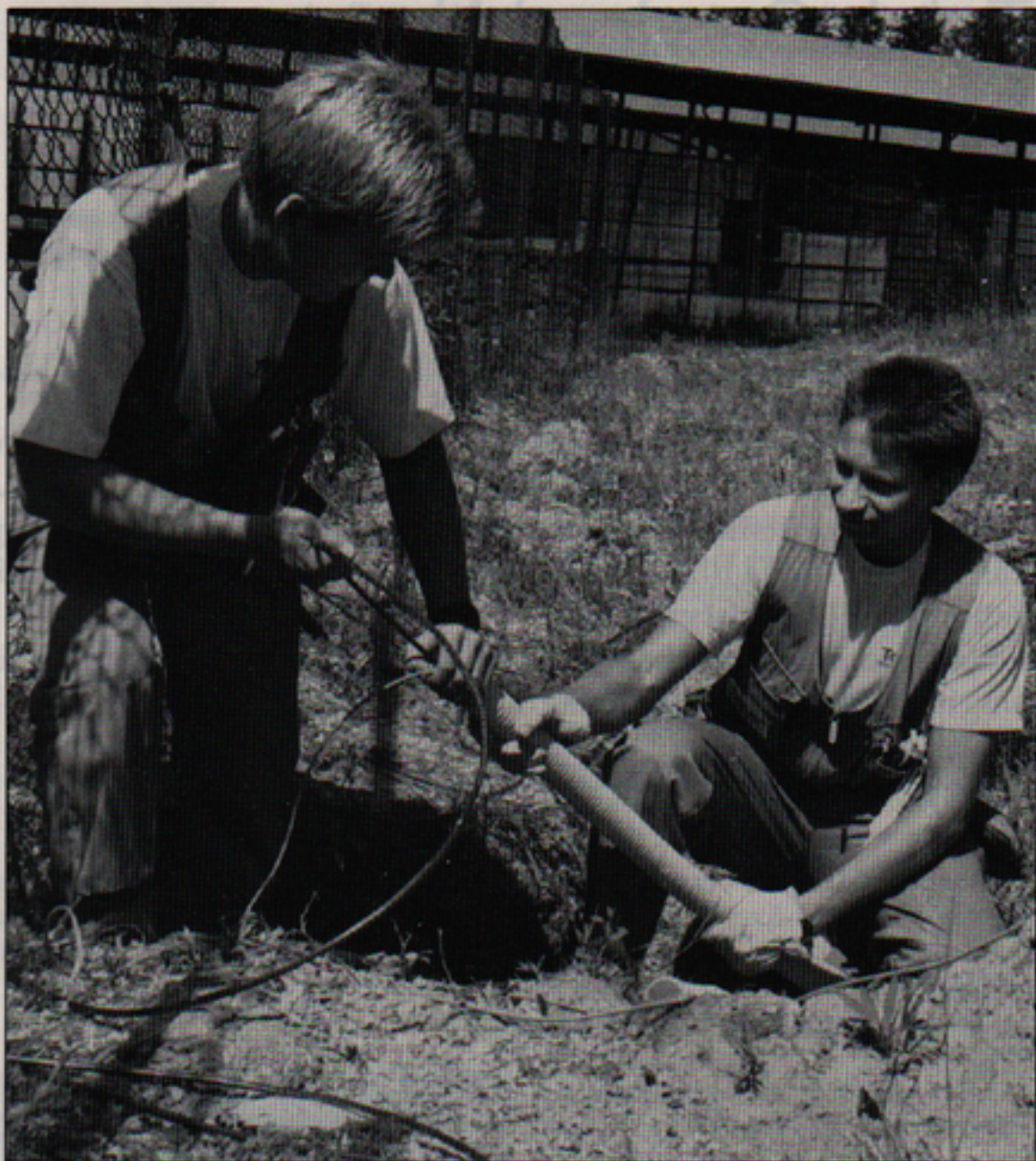
Arne Larsson och Nicola Johansson sliter med fiberkabeln som skall binda samman Hasselfors Bruks alla byggnader i ett datanät.
