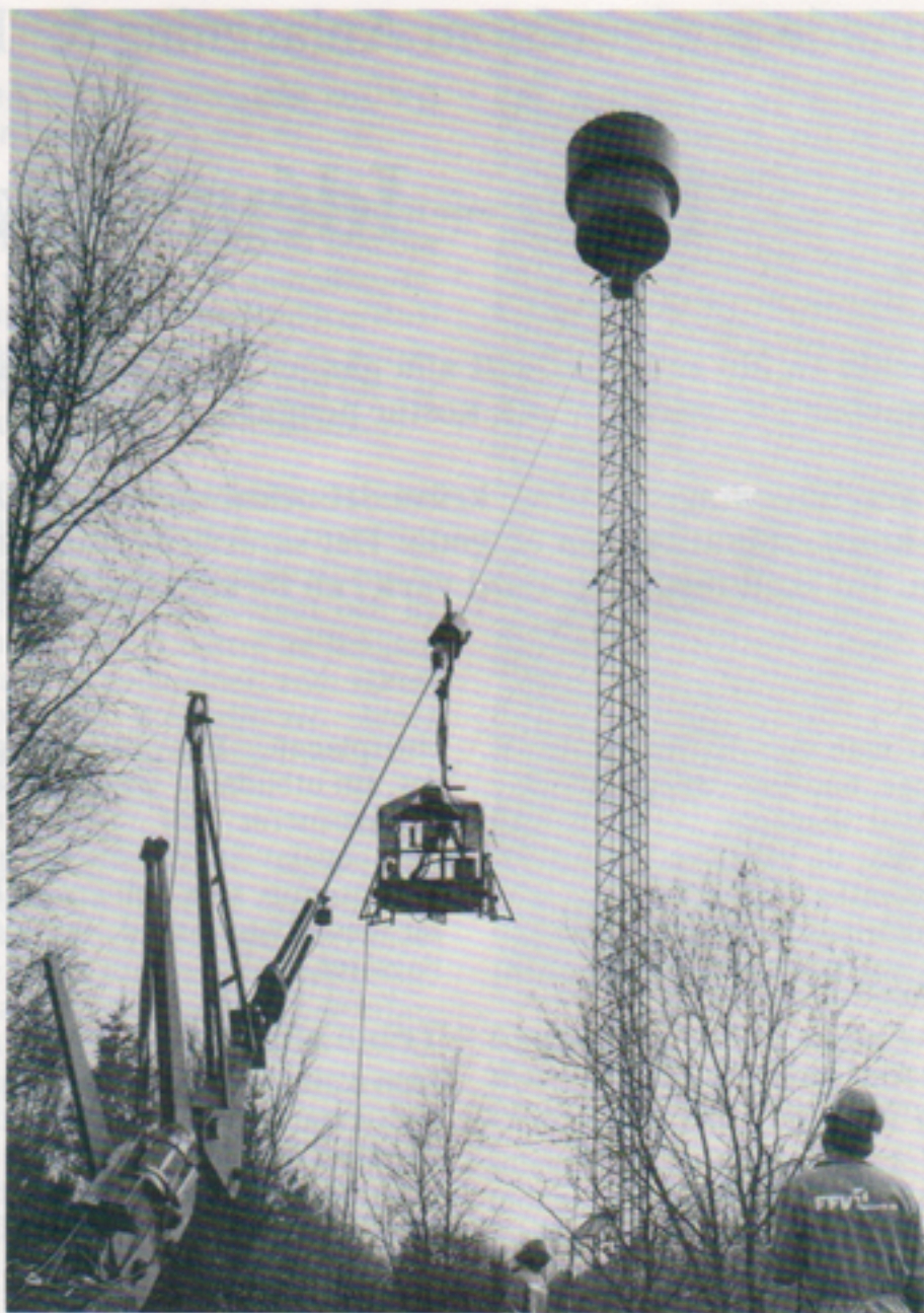
Kjell Eriksson och Birger Westman på Anläggning & Radar arbetar här med linsmörjning av staglinor till torn och master.
