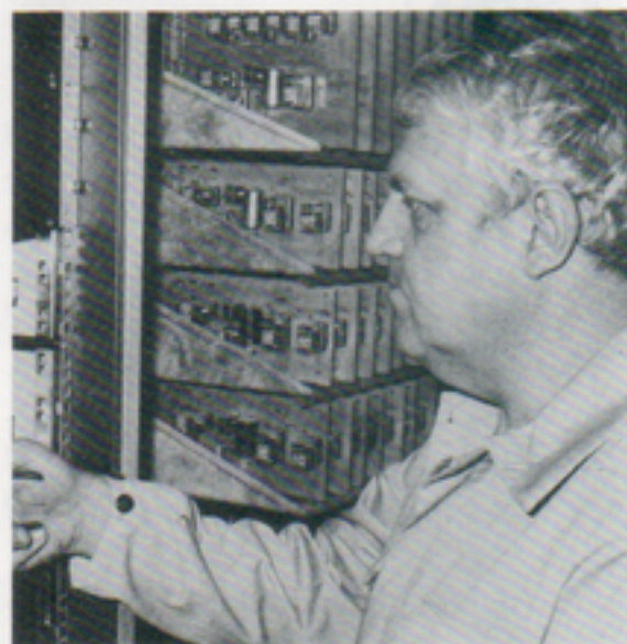
Inge Cronart arbetade med montage och driftsättning av övningsanläggningen.
