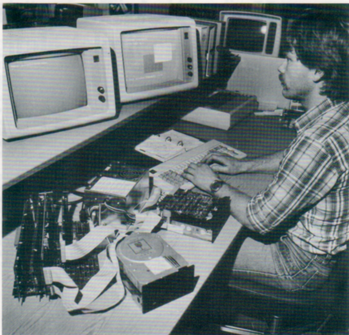
Lars Fransson arbetar här vid Service divisionens systemtestutrustning för enheter ur IBMs persondatorer.
