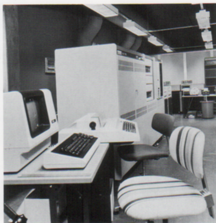
Interiör från nya Datacenter.
