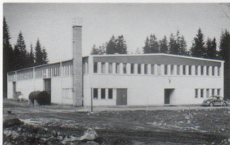
Första byggnaden på Ljungadalstomten – nuvarande byggnad F.
