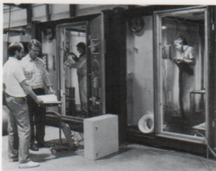
Installation av elektronikutrustning hos division Anläggning & Radar.
